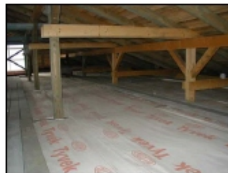
Príklad riešenia zateplenia pod novou strechou. Izolácia CLIMATIZER PLUS následne prekrytá difúzne otvoreným Tyvekom.
